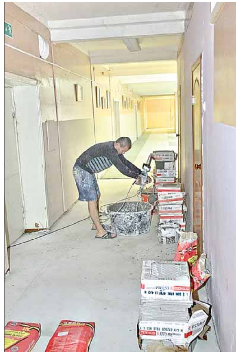
Ремонтные работы в школах города уже начались.
