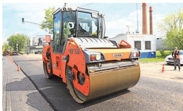
КАПИТАЛЬНЫЙ РЕМОНТ УЛИЦЫ КАЛИНИНГРАДСКОЙ
