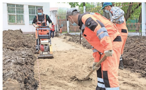
РАБОТЫ ПО БЛАГОУСТРОЙСТВУ АКУЛОВСКОГО ВОДОКАНАЛА
