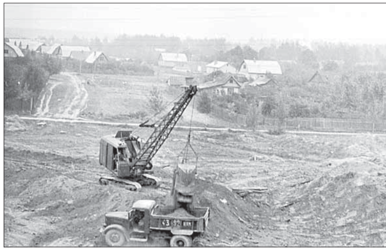
Строительство проспекта Космонавтов. Конец 1970-х годов.
