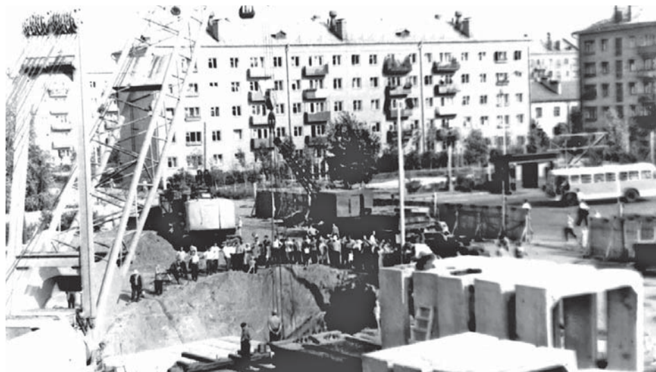
Станция Подлипки-Дачные. Строительство подземного перехода. 1966 год.
