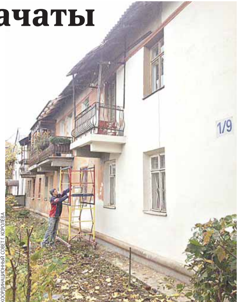
Ремонт фасада дома 1/9 по ул. Пушкина.
