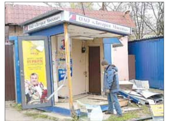
У станции Подлипки демонтирован очередной киоск, установленный с нарушением требований.
