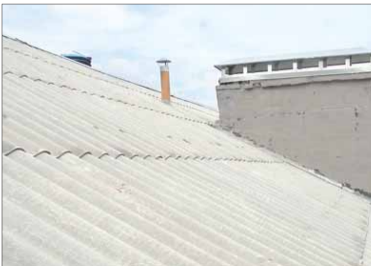
Отремонтированная крыша дома 18, к. 2, по ул. Аржакова.
