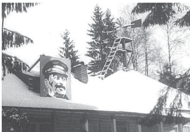
Ветряной двигатель, собранный руками подростков, был установлен на крыше пионерского клуба.
