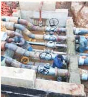
Длительность ремонтных работ составила чуть более четырёх месяцев. Проложено **410** метров теплотрассы из **6** трубопроводов, общая протяжённость которых составила порядка **1,5** км, установлено более мощное оборудование, **3** тепловые камеры и выполнен монтаж тепломеханического оборудования.
