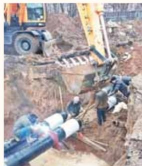
В целях ликвидации дефицита мощности тепловых сетей сотрудниками ОАО «Теплосеть» проведён комплекс работ по строительству тепловой сети на Октябрьском бульваре. В рамках реконструкции для увеличения пропускной способности проложено **650** м теплотрассы из **4** трубопроводов, общая протяжённость которых составила **1,3** км. Также проведены работы по устройству **5** тепловых камер, в которых выполнен монтаж тепломеханического оборудования.
