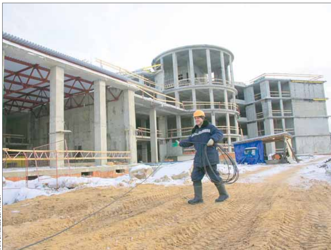
Строительство школы на улице Пионерской. Корпорация «Энергия» выделила для неё 3,8 гектара собственной земли и 200 млн рублей. Открытие школы намечено на 1 сентября 2016 года.
