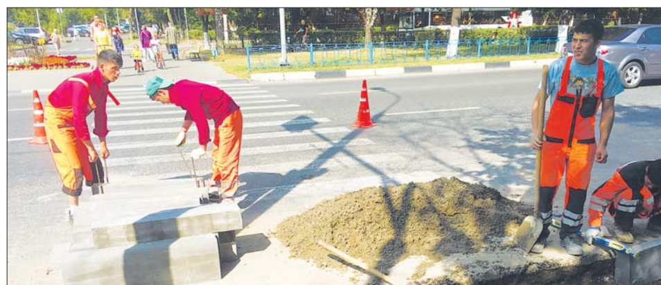
Рабочие МБУ «Автобытдор» выполняют занижение бордюрного камня на проспекте Королёва.
