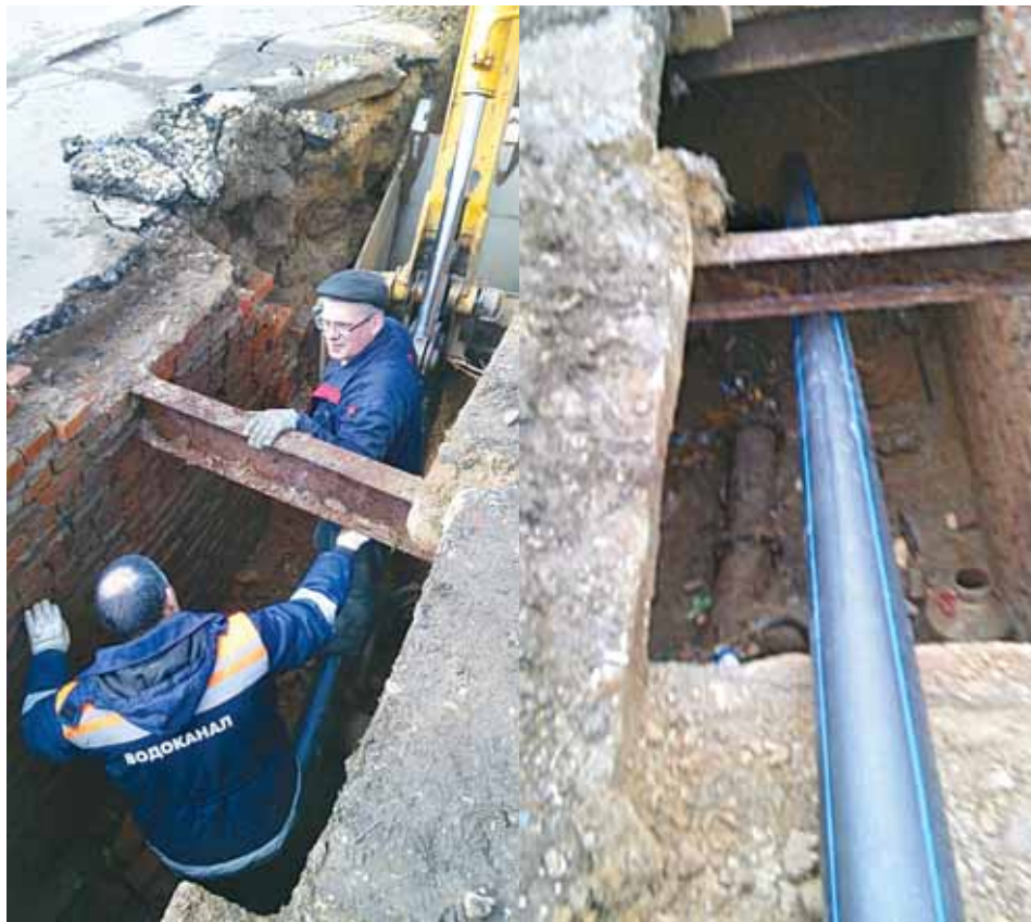
Работники «Водоканала» подключают сети Юбилейного к сетям Королёва.
