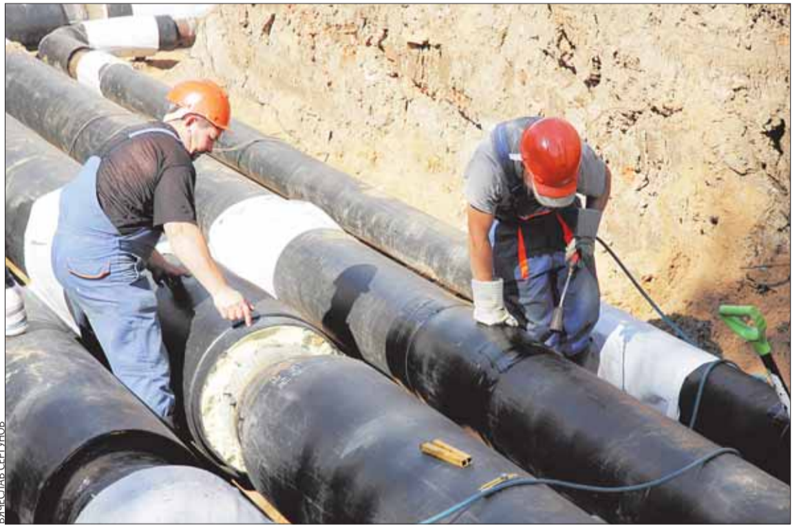
На теплотрассе у д. 5 по ул. Пионерской укладывают новые полиуретановые трубы.
