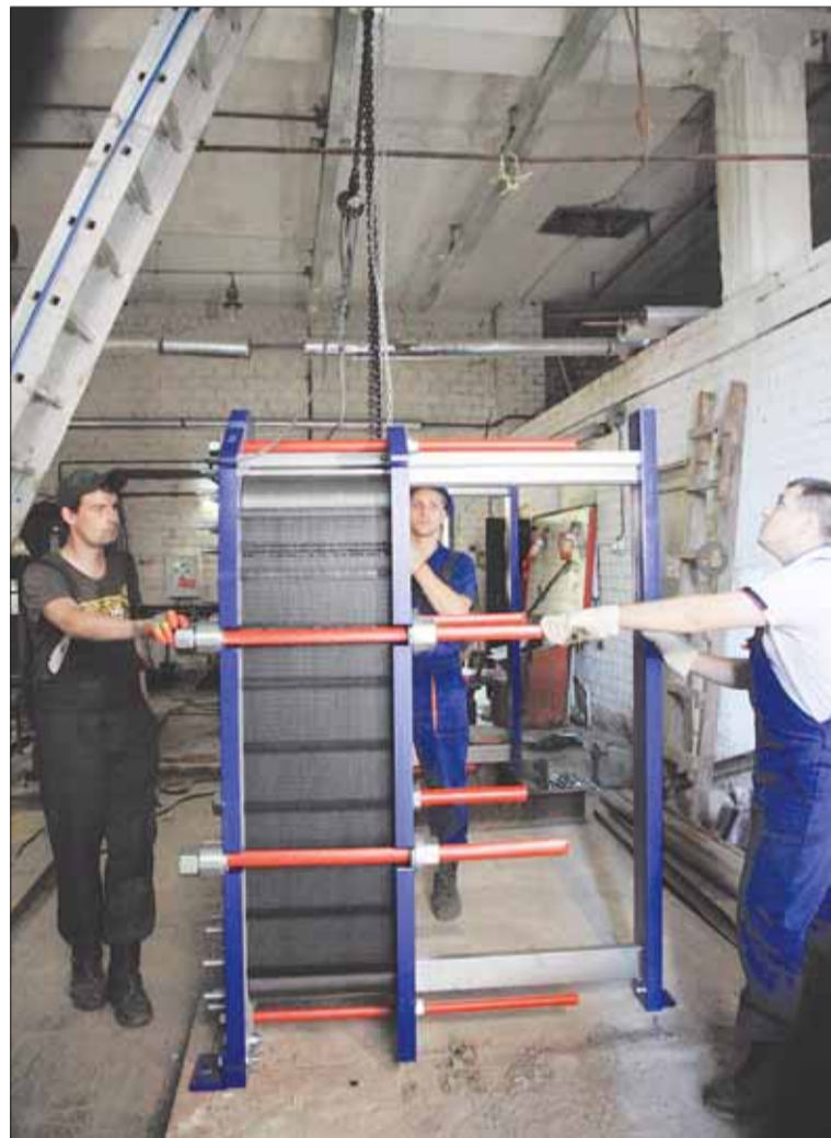
В ЦТП №6 на ул. Ленинской монтируют новые теплообменники производства компании «Альфа Лаваль» (г. Королёв).
