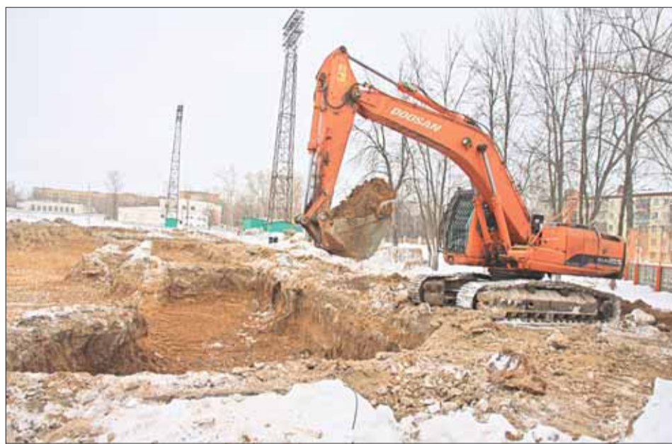
Строительные работы на стадионе «Вымпел».
