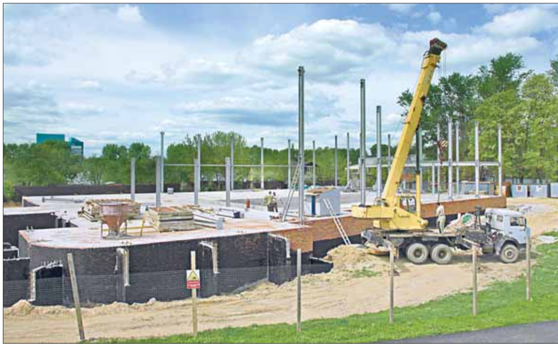
Строительство ФОКа на стадионе «Металлист».
