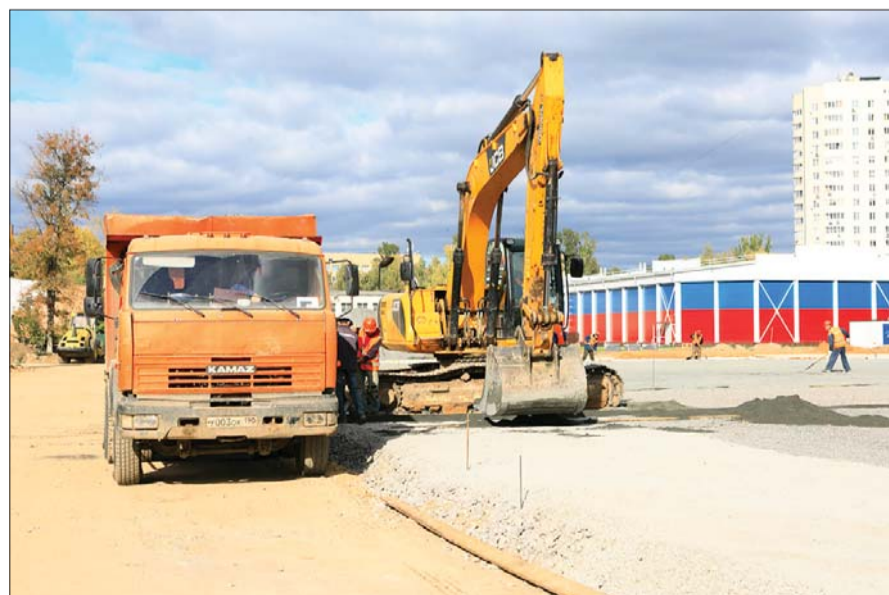
Реконструкция стадиона «Вымпел».
