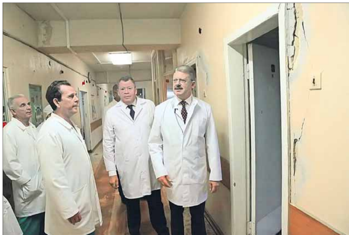
Городская больница №1 находится в плачевном состоянии.
